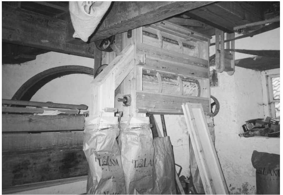
Ingenieuze, zelfgemaakte (ascania)buil op de eerste zolder.
